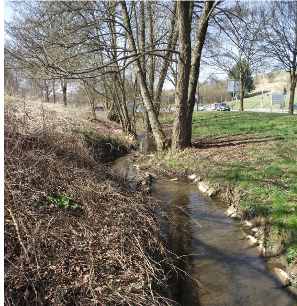
Die allgemeine Degradation des ausgebauten Humpfenbachs in Nürtingen wurde als „schlecht“ bewertet.
