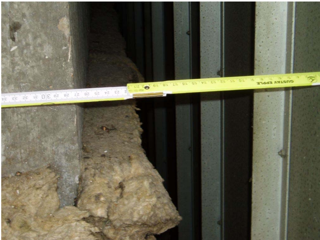
Fassadenaufbau Dämmung Bestand (wsa 2009)
