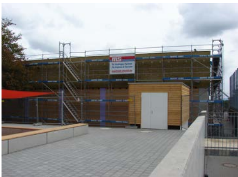
2. Bauabschnitt / Sporthalle (Westansicht)
