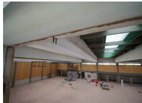
2. Bauabschnitt / Sporthalle (Hallenraum)
