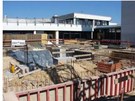
1. BA, Erdarbeiten, Gründung
