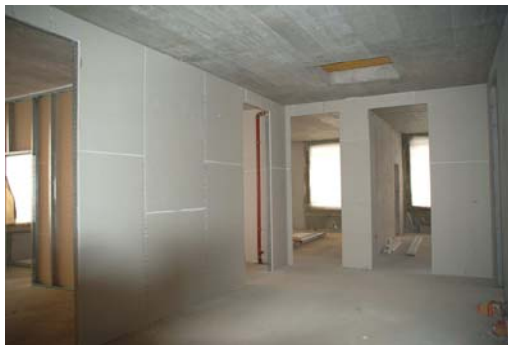
1. BA, Einbau Trennwände
