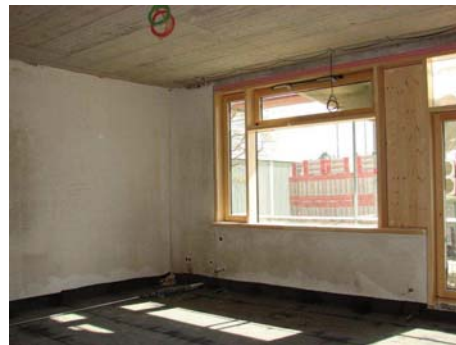
1. BA, Einbau Fenster
