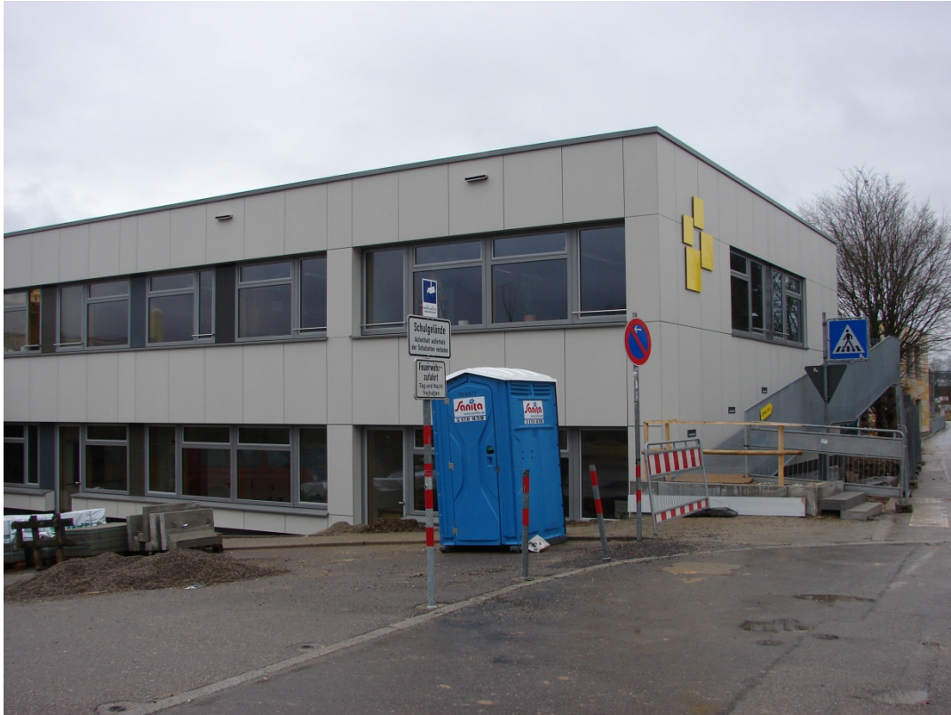
3. Bauabschnitt (Außenansicht Werkbereich GB Schule)
