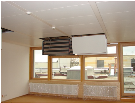
3. Bauabschnitt Aufstockung: Kühlelemente (vor Einbau)
