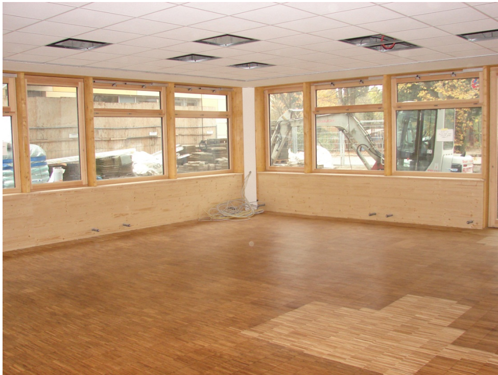
3. Bauabschnitt GB-Schule: Beispielhafte Innenansicht (mit ausgebessertem Bodenbelag)
