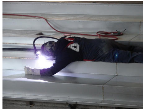
3. Bauabschnitt Lehrschwimmbecken: „Sportliche“ Schweißarbeiten
