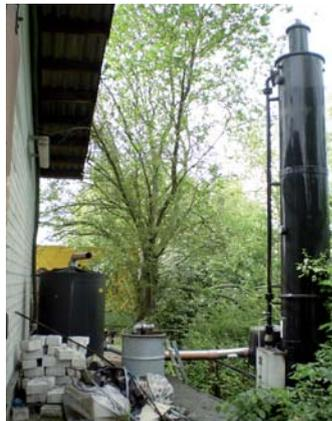
Strippturm mit Aktivkohle-einheit zur Beseitigung von leichtflüchtigen Schadstoffen aus dem Grundwasser.
