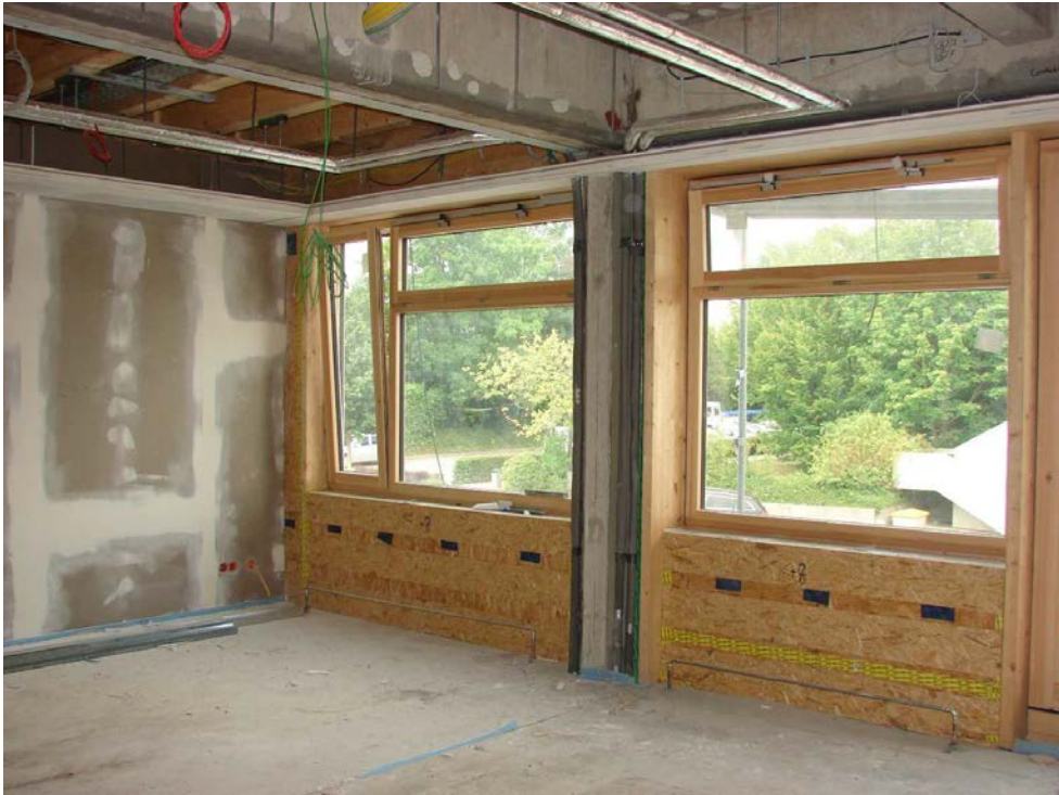
3. Bauabschnitt Bereich Aufstockung: Beispielhafte Innenansicht der Fassade
