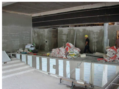
3. Bauabschnitt Lehrschwimmbecken: Verputz der Wände in Arbeit
