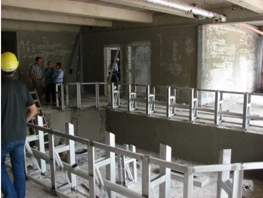
3. Bauabschnitt (Therapiebecken: Unterkonstruktion der neuen Umrandung mit Überlaufverrohrung)
