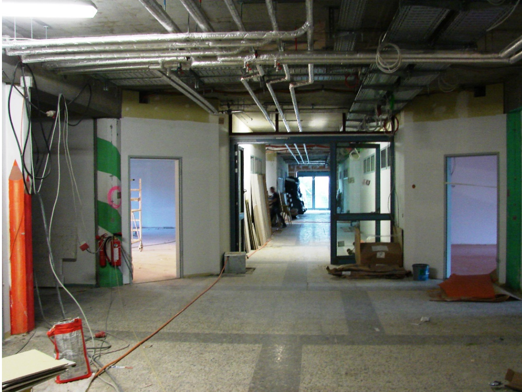
5. Bauabschnitt: Rohmontage Haustechnik
