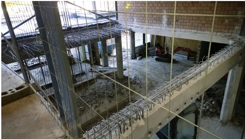
Bauabschnitt 6.1: Rückgebaute Küchendecke
