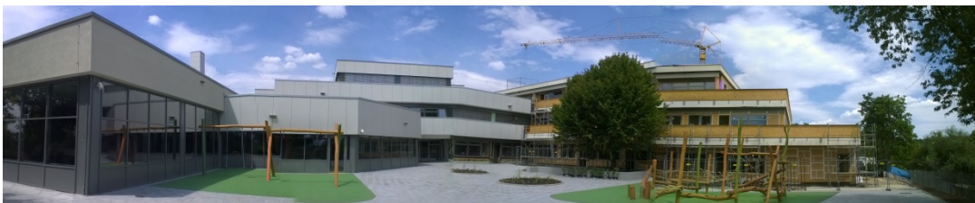
Bauabschnitt 4: Hangseitige Außenanlagen
