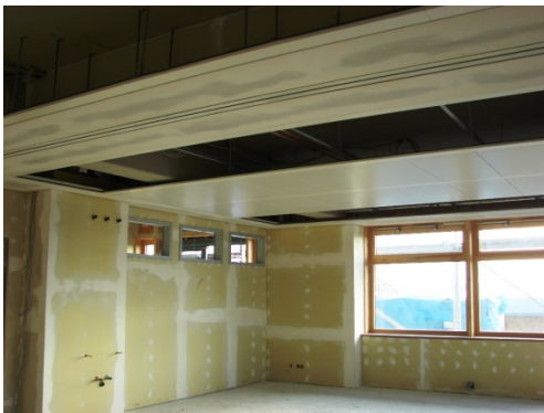
Bauabschnitt 5: Kühldeckenmontage
