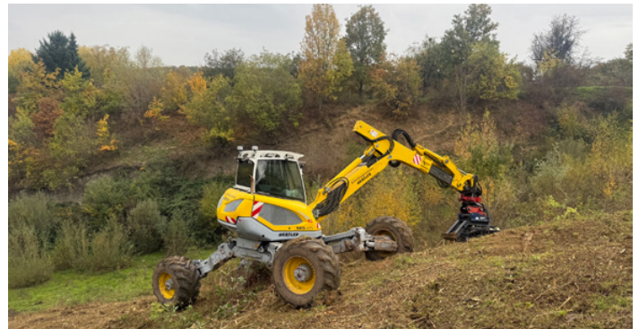
Schreitbagger (Spinnenbagger) im Einsatz (Bild: Matthias Hertler)
