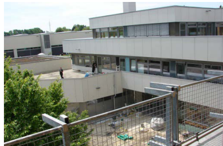
Fertiggestellte Fassade GB-Schule (Talseite)
