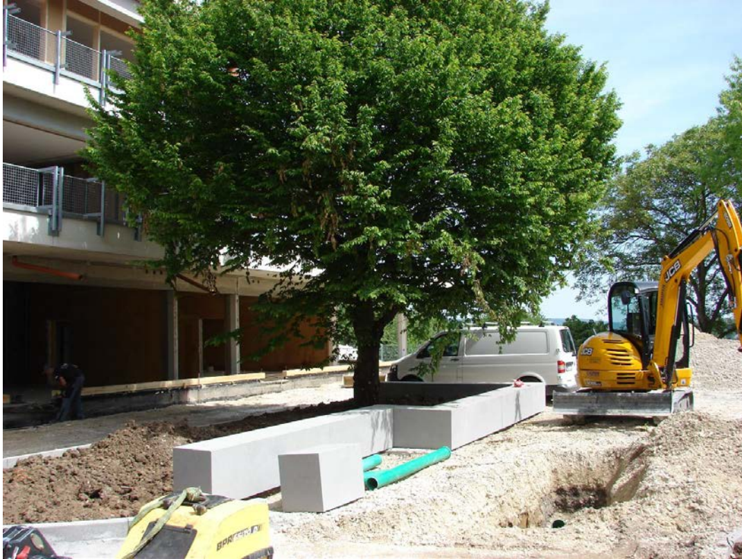
Arbeiten im Innenhof, links im Bild BA 5
