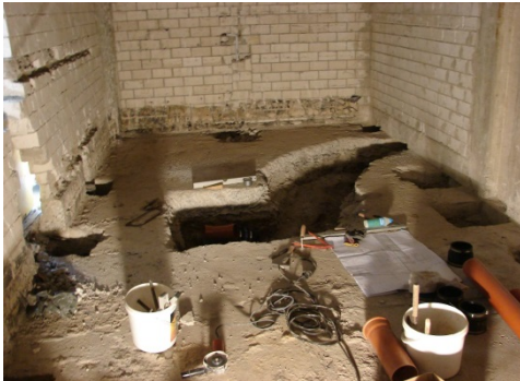
5. BA aufgestemmt Bodenplatte zur Grundleitungssanierung
