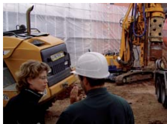
Sanierung eines kommunalen Altstandortes durch Entfernung belasteter Bereiche.
