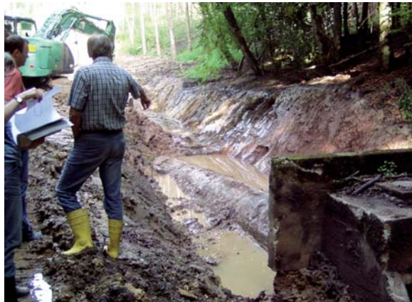
Sanierung einer Verdolung im Einlaufbereich eines ehemaligen Müllplatzes zur Verhinderung der Ausbreitung von Schadstoffen ins Gewässer.
