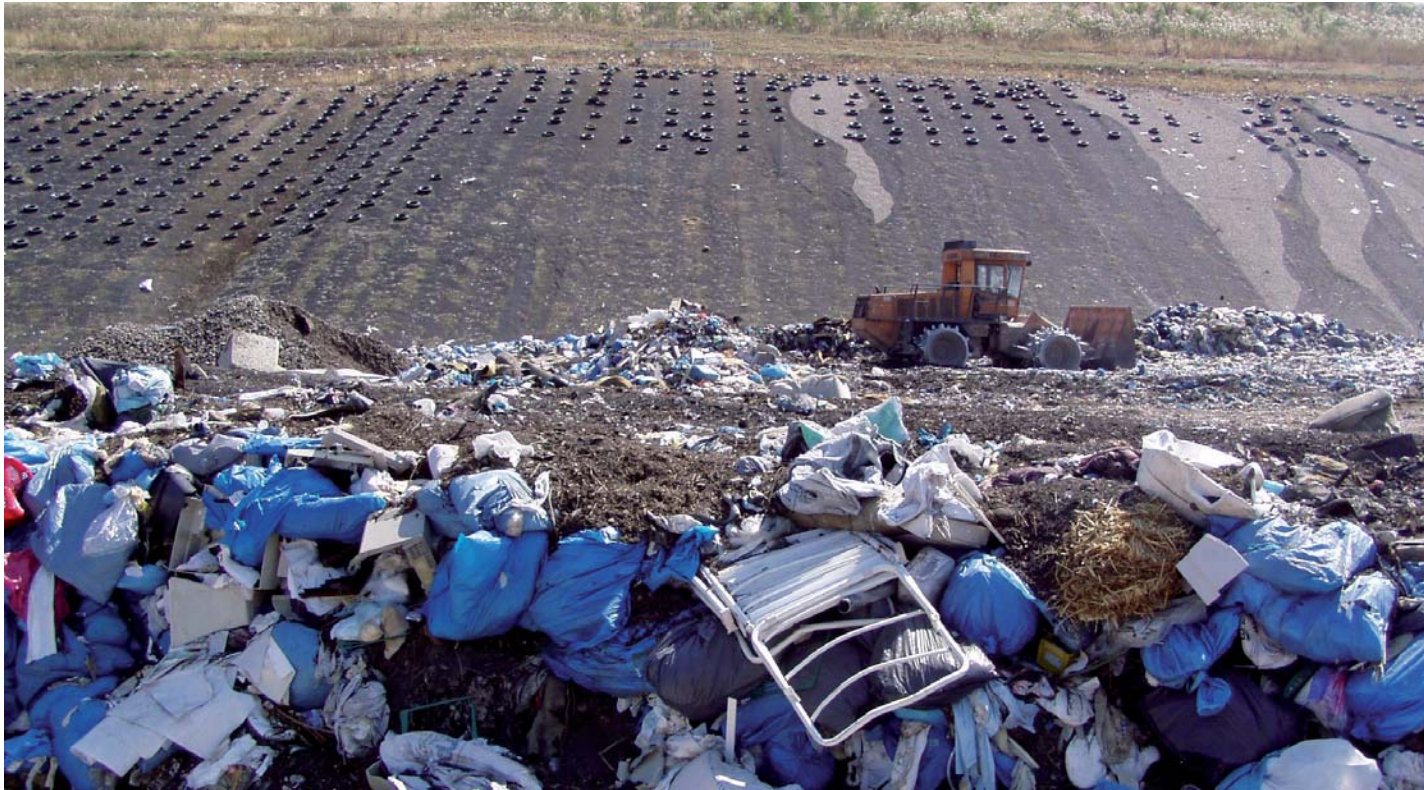
Einbau von Hausmüll in eine Deponie.
