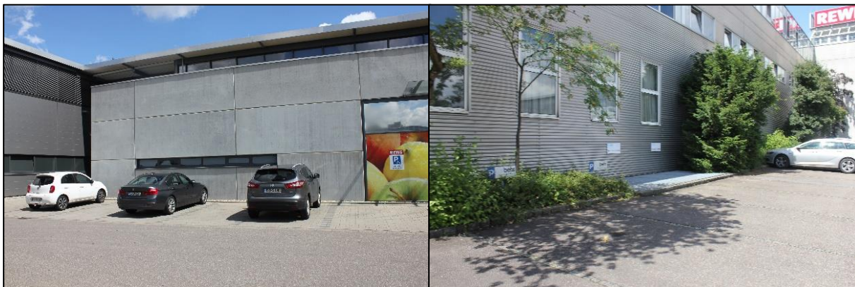
Abbildung 25: Positionierung der Ladesäulen inkl. umgewidmter Stellplätze am Standort Behrstraße 94, Wendlingen am Neckar
