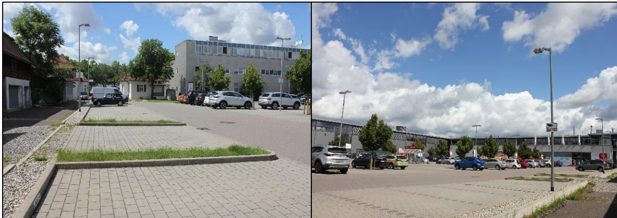
Abbildung 23: Übersicht Parkplatz Behrstraße 94, Wendlingen
